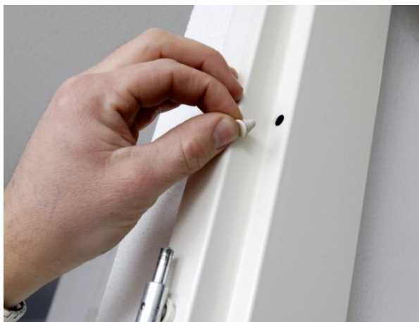
Stalen kozijn (wordt) voorzien van afdekdopje
